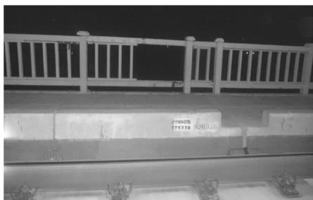
图1 铁路护栏缺损
